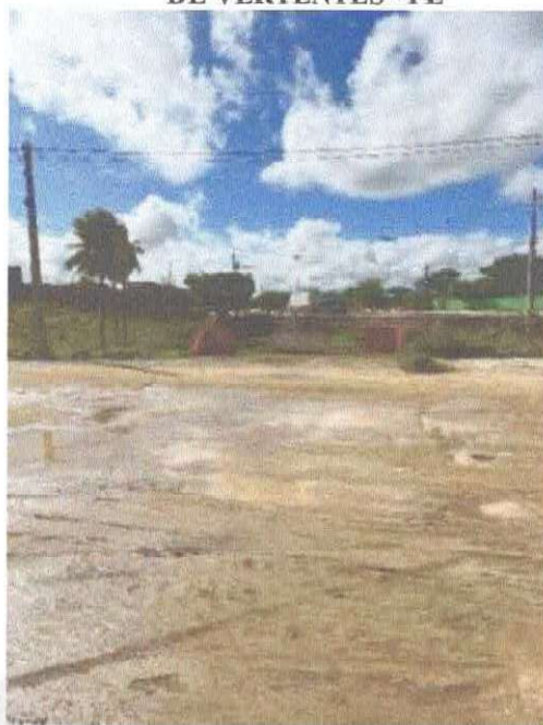
Figura 4. CONSTRUÇÃO DE UM CANAL DE DRENAGEM NO MUNICÍPIO DE VERTENTES - PE
