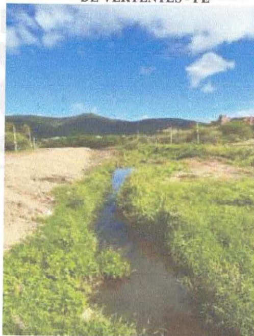
Figura 5. CONSTRUÇÃO DE UM CANAL DE DRENAGEM NO MUNICÍPIO DE VERTENTES - PE
