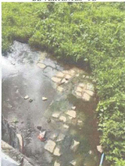
Figura 1. CONSTRUÇÃO DE UM CANAL DE DRENAGEM NO MUNICÍPIO DE VERTENTES - PE
