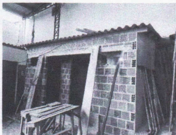
FOTO 1: EXECUÇÃO DO BANHEIRO;
