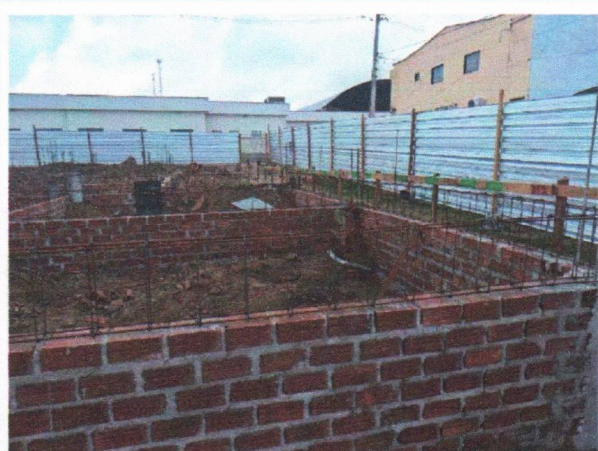
FOTO 4: EXECUÇÃO DO EMBASAMENTO, PESCOÇO DE PILAR E BALDRAME;
