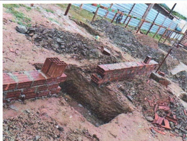
FOTO 1: EXECUÇÃO DA ESCAVAÇÃO DAS SAPATAS;
