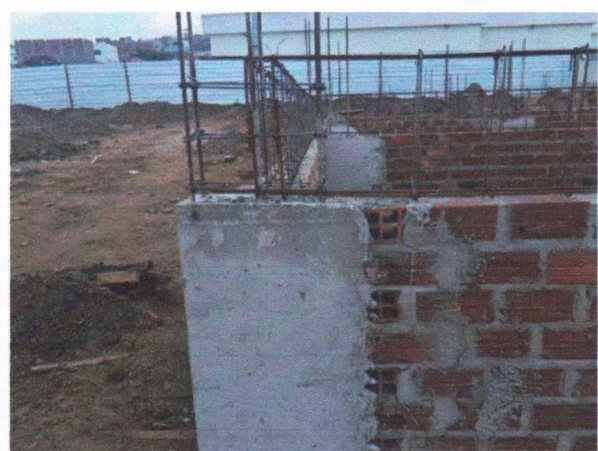
FOTO 6: EXECUÇÃO DO EMBASAMENTO, PESCOÇO DE PILAR E BALDRAME;;
