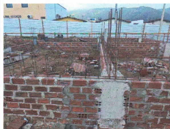
FOTO 5: EXECUÇÃO DO EMBASAMENTO, PESCOÇO DE PILAR E BALDRAME;
