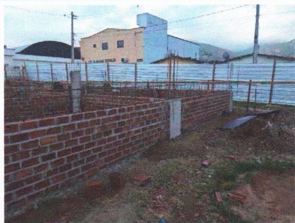
FOTO 2: EXECUÇÃO DO EMBASAMENTO, PESCOÇO DE PILAR E BALDRAME;
