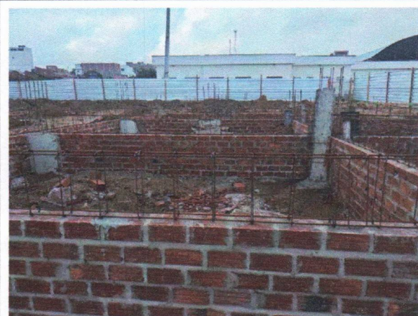
FOTO 3: EXECUÇÃO DO EMBASAMENTO, PESCOÇO DE PILAR E BALDRAME;
