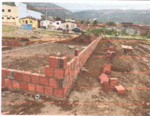
FOTO 1: EXECUÇÃO DOS BARRACÕES;
