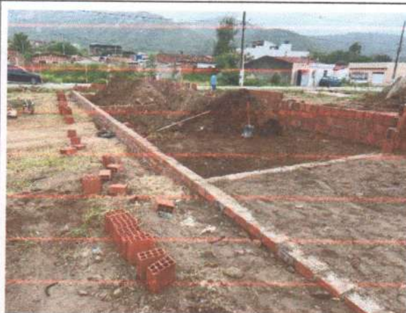
FOTO 2: EXECUÇÃO DOS BARRACÕES;
