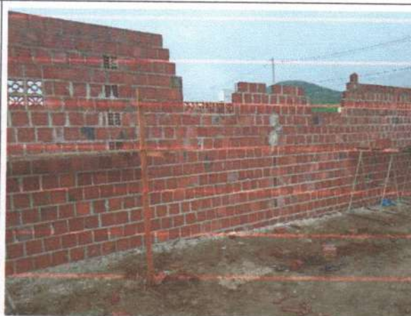
FOTO 4: EXECUÇÃO DOS BARRACÕES;
