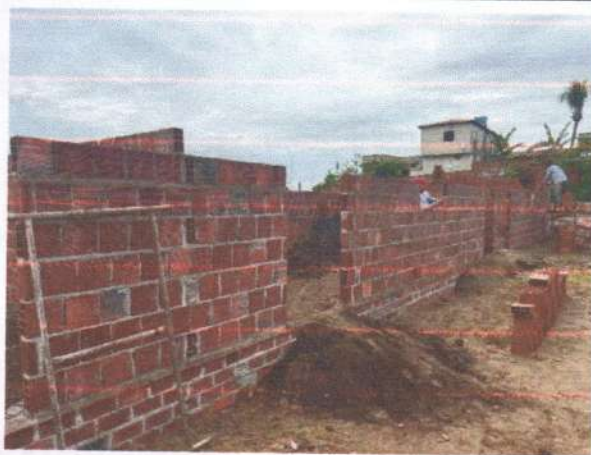
FOTO 3: EXECUÇÃO DOS BARRACÕES;
