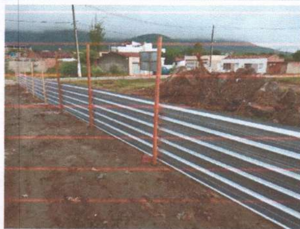
FOTO 3: EXECUÇÃO DO TAPUME;
