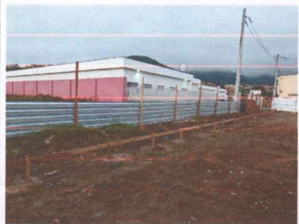
FOTO 6: EXECUÇÃO DO TAPUME;
