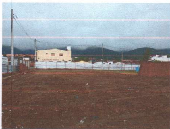
FOTO 5: EXECUÇÃO DO TAPUME;
