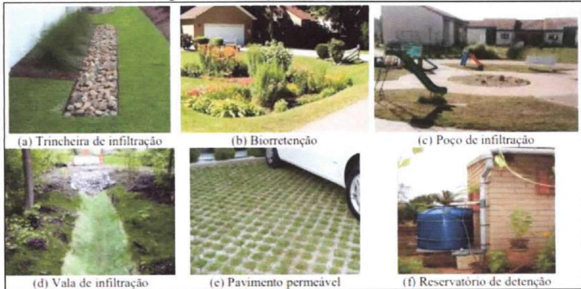
Figura 126 - Exemplos de controles na fonte.
