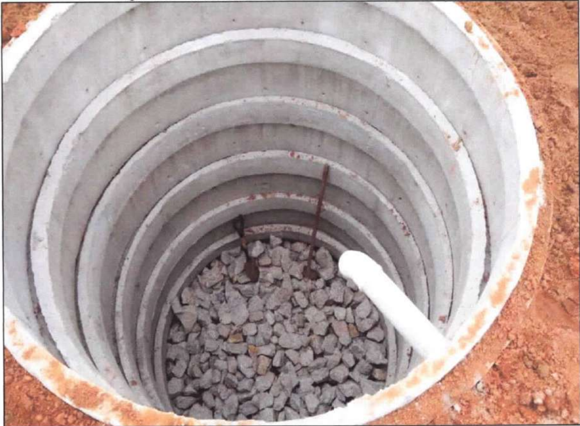
Figura 59 - Sistema individual de tratamento, sumidouro.
