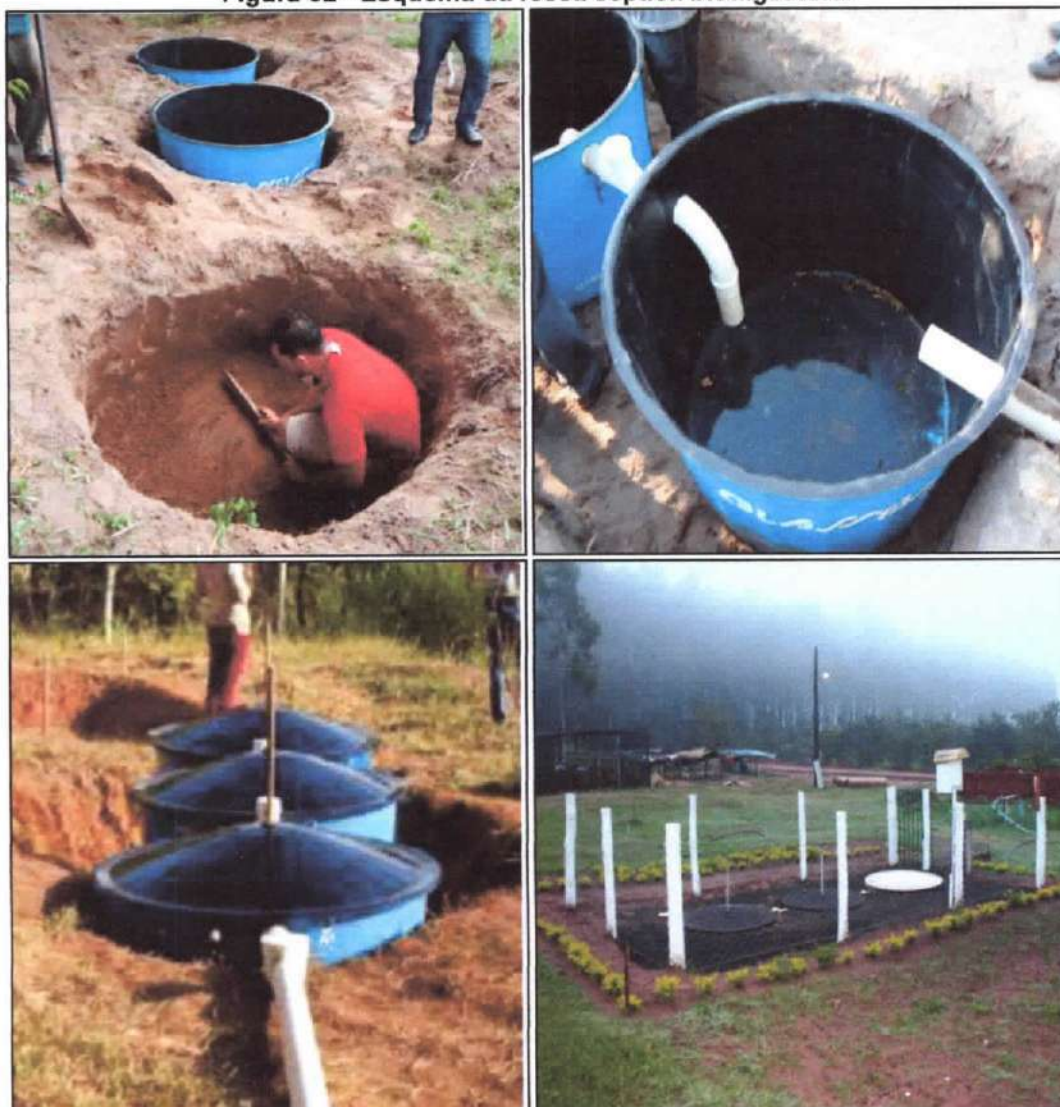
Figura 62 - Esquema da fossa séptica biodigestora.
