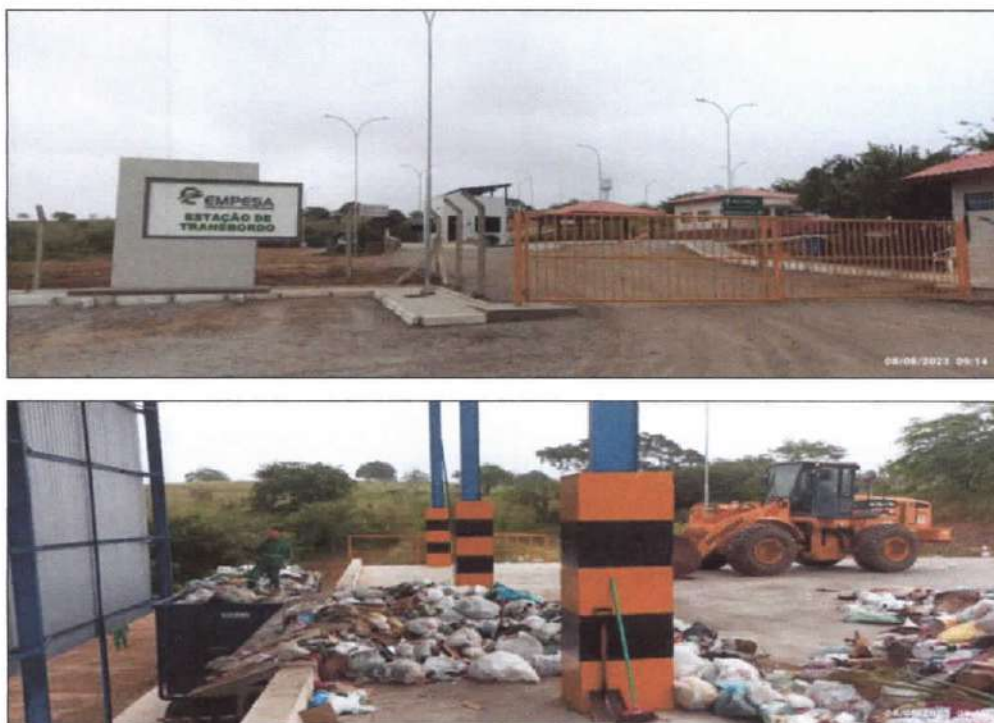
Figura 30 - Estação de Transbordo de Vertentes.
