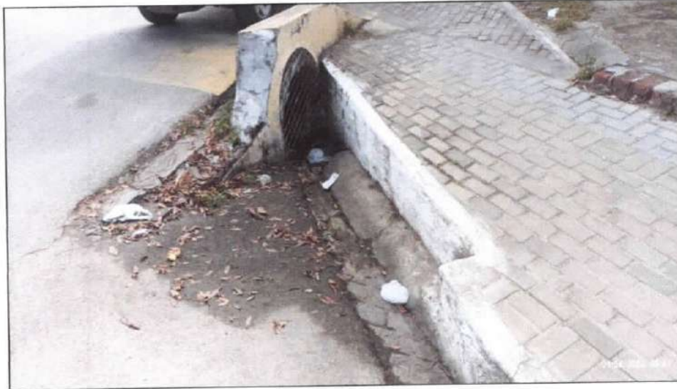
Figura 52 - Dispositivos de microdrenagem em Vertentes.
