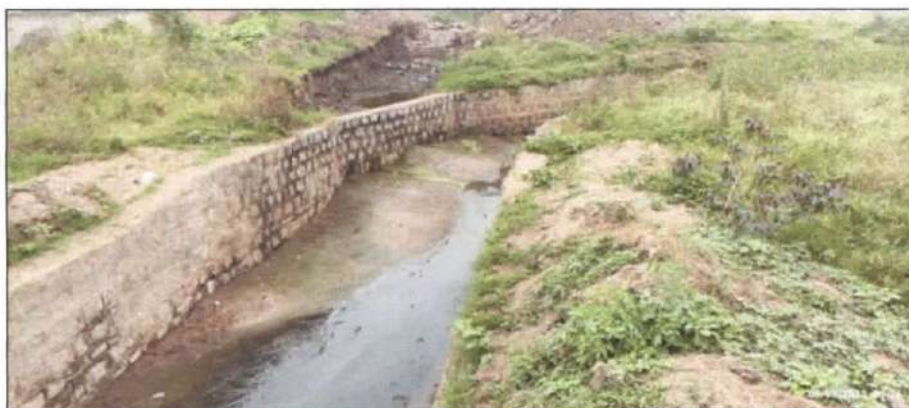
Figura 51 - Macrodrenagem no município de Vertentes.
