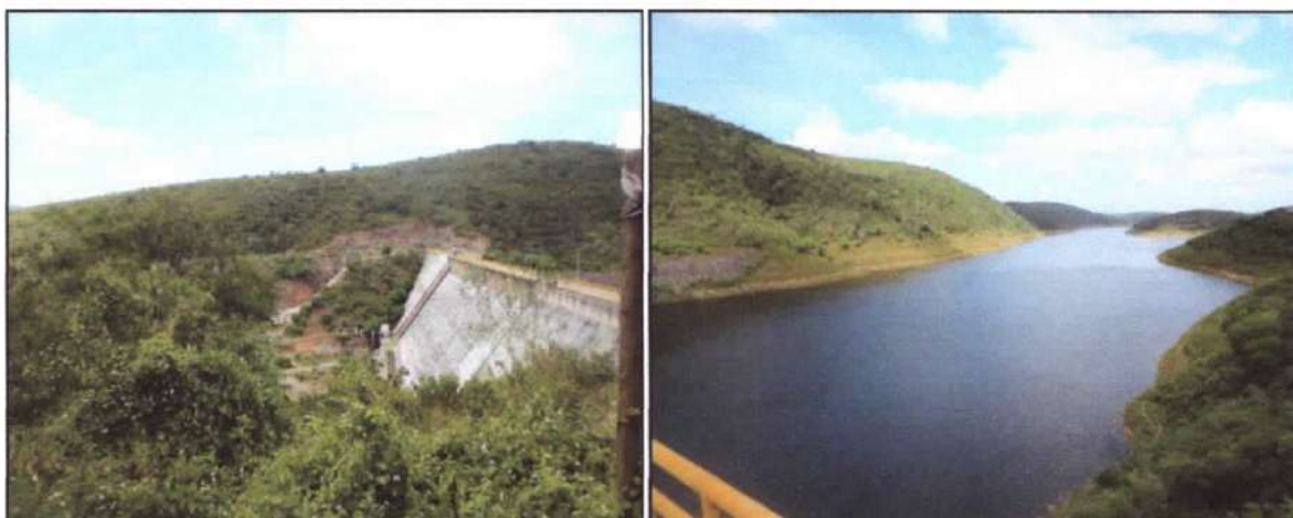
Figura 20 – Barragem de Jucazinho.
