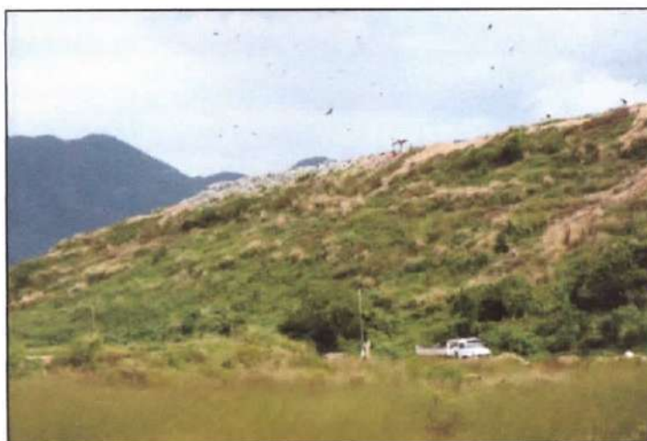
Figura 42 - Exemplo de aterro controlado.
