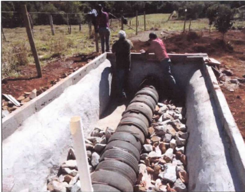
Figura 70 - Construção de círculo de bananeira.
