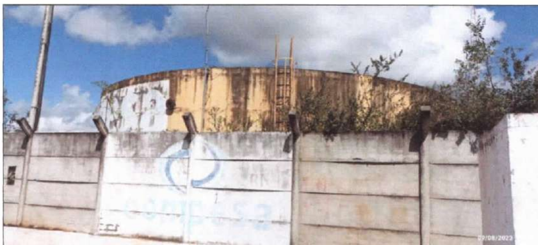
Figura 21 - Reservatório da COMPESA em Vertentes.
